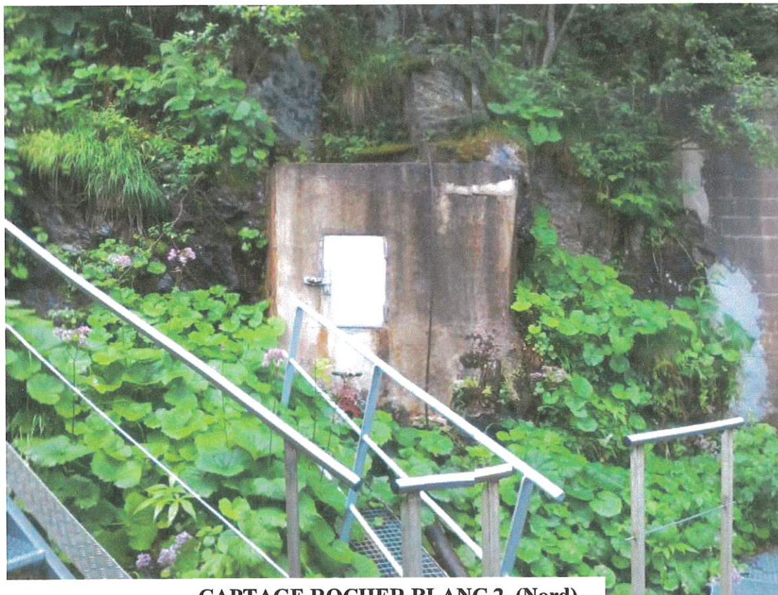
CAPTAGE ROCHER BLANC 2 (Nord)
