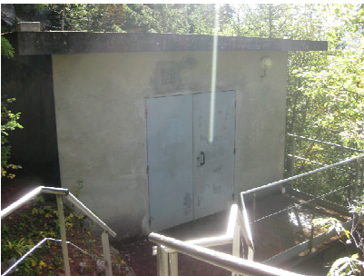
Accès chambre de vannes
