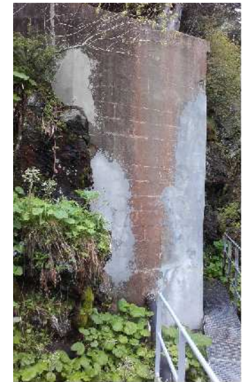
Vue de l'ouvrage depuis la passerelle
