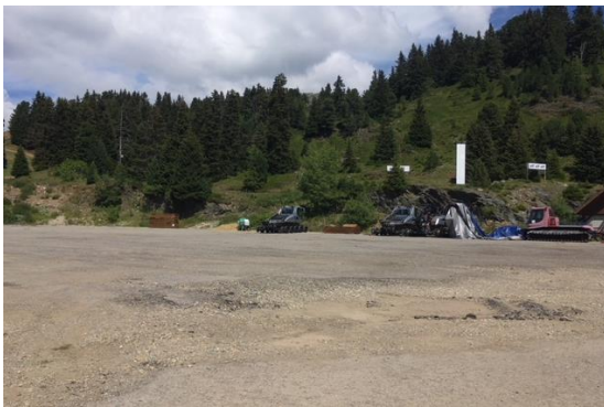
Plateforme technique plane correspondant au 1 er plan largement artificialisé et libre de construction
