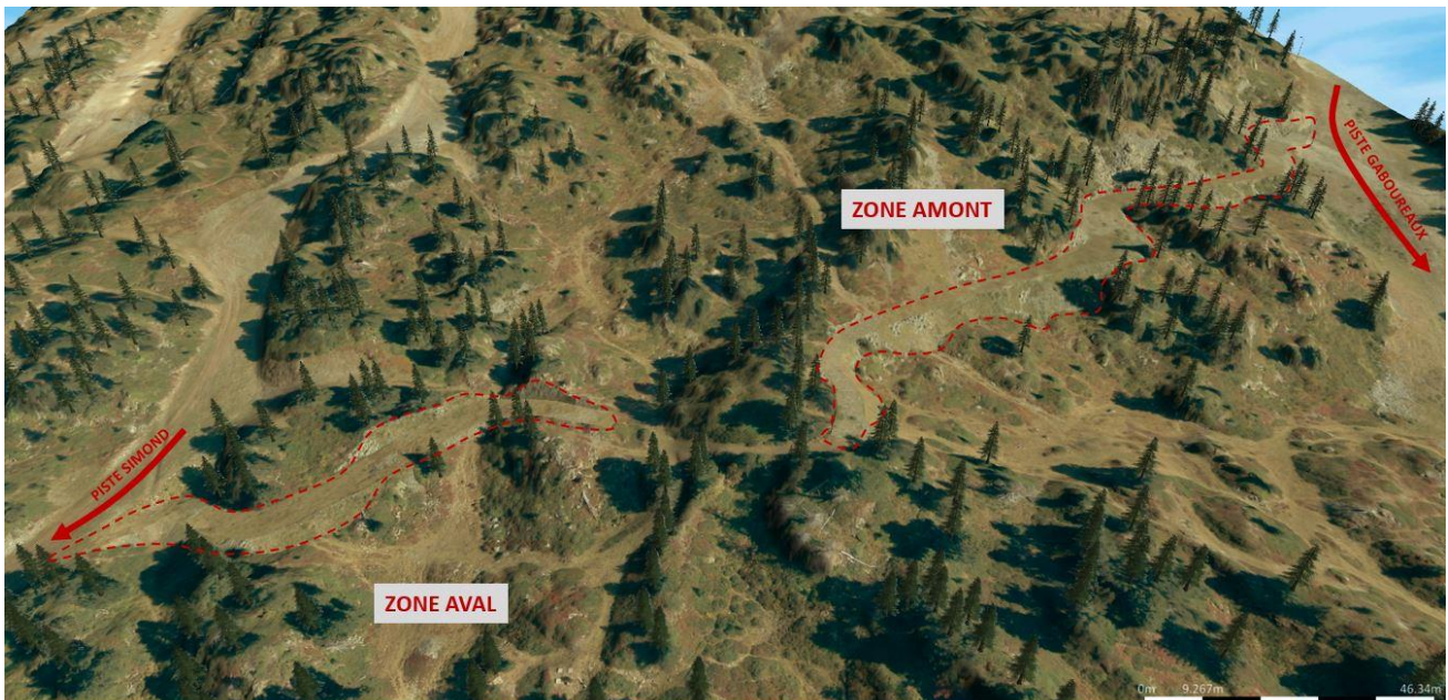
Emprise des terrassements du Chemin Pisteurs
